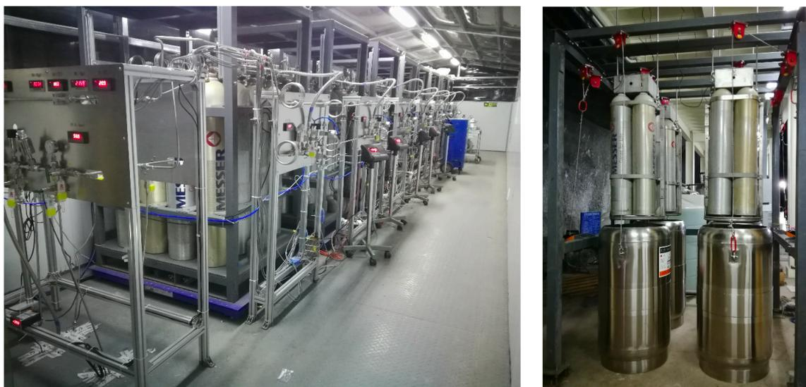
图 2.7 PandaX-4T 的氙气室温存储系统 (左) 和液氮低温回收系统 (右)。室温系统使用 8 组地秤, 每组放置 16 个气瓶。低温系统使用 4 组杜瓦, 每组放置 4 个气瓶。系统配备温度计、压力计、气动阀、电磁阀、手动阀。使用 Messier 气瓶, 标称容积为 50 L, 可以容纳 40 kg 高压氙。
