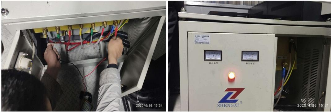
图 5-54 左图，隔离变压器安装电压检测。右图，隔离变压器正常工作，输入电压 380 V，输出电压 380 V，输入电压为 380 V 的三相电源。每两相电压源之间电势为 380 V，单独某一相到地的电势为 220 V。
