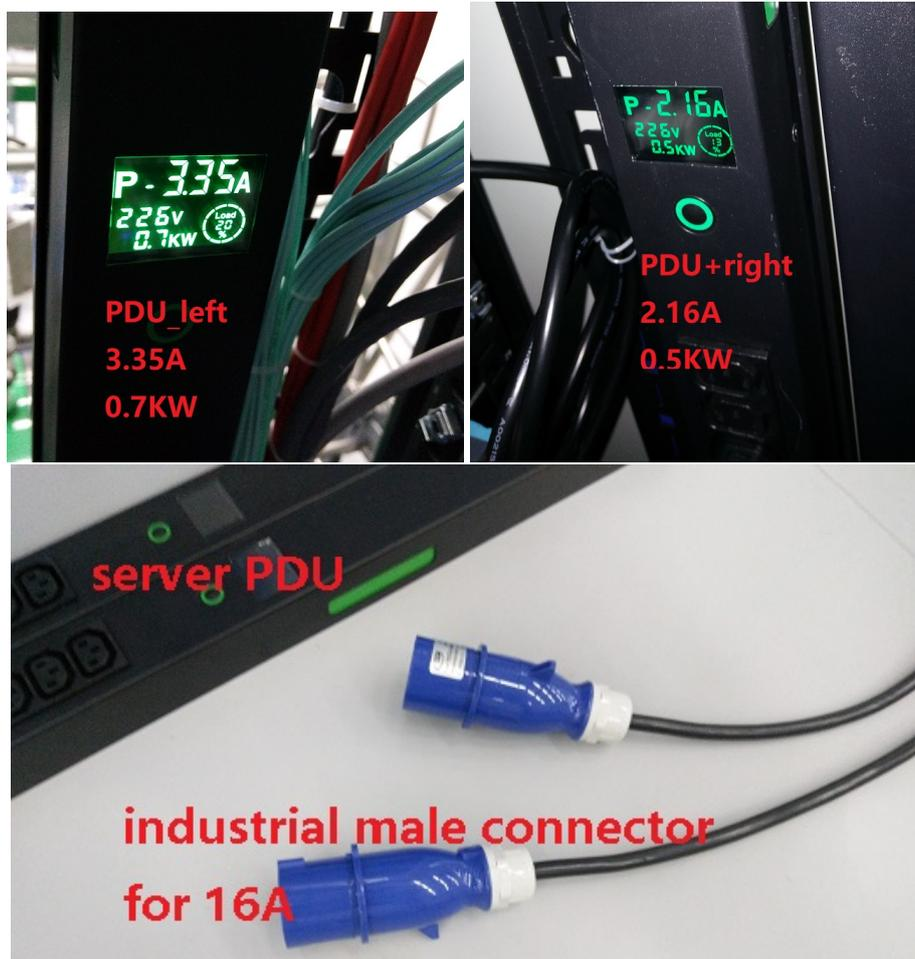
图 5-56 左上图，服务器左侧 PDU 正常输出电流 3.35 A，总功率 0.7 kW。右上图，服务器右侧 PDU 正常输出电流 2.16 A，输出功率 0.5 kW。DAQ 所有的服务器至少有两个电源模块，每个电源模块个连接一个 PDU，这样当一组供电线路出现问题的情况下，另一组供电线路依然可以确保服务器正常工作。下中图，电子学实验搭建期间用于电源线转接的 16 A 3 芯工业接头 (蓝色的公母接头)。实验中有两种规格的工业接头，服务器机柜和 VME 机柜用电功率较大，使用了 25 A 规格的工业接头，其他设备供电均采用了 16 A 规格的工业接头。
