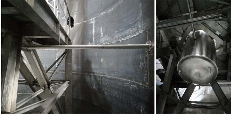
图 5-17 DD 中子刻度隧道。左图是在水屏蔽体内部平视图，中子刻度隧道从水屏蔽体外穿进来，穿过了水屏蔽体。右图是仰视图，中子刻度隧道穿过水屏蔽体后抵达外罐。
