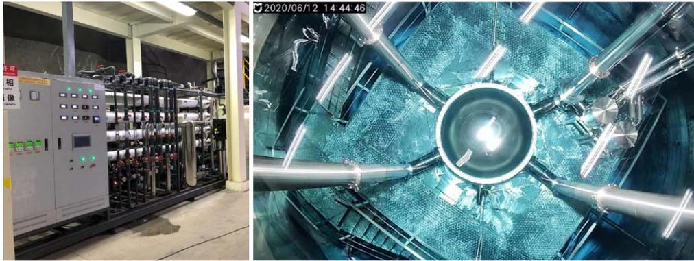
图 5-21 左图，PandaX4T 超纯水系统；右图，水屏蔽实物图，由于白炽灯中的红光成分被超纯水吸收了，所以水屏蔽体呈现出淡蓝色。
