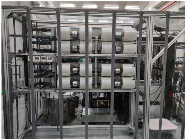
图 5-58 用于电子学设备制冷的四台空调风机。四台空调风机出风口在水罐人孔上方，空调的温度调，并且我们在两台高压机箱之间、服务器机柜、VME 机箱间以及空调出风口安装有 6 个 PT100 温敏电阻用于实时监测空调房内部的温度。
